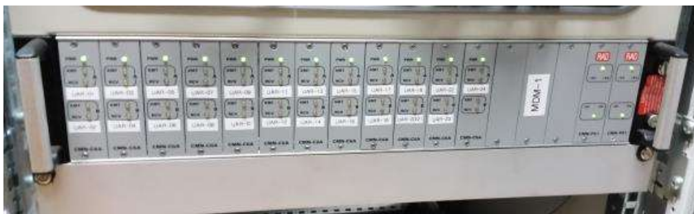
Figura 12 – Rack con módems RS232 del CDA.
