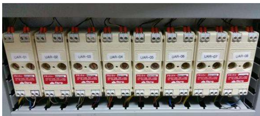
Figura 11 – Protección contra sobretensiones del CDA.
